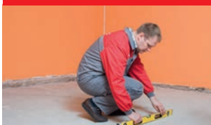
3. Подготовка поверхности пола
