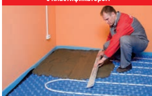
10. Заливка бетонной стяжки с пластификатором
