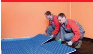
6. Укладка утеплителя (пенополистирол с покрытием)
