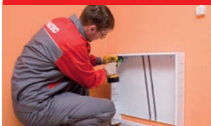
1. Монтаж коллекторного шкафа
