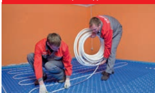
7. Укладка петель теплого пола (металлополимерная труба VALTEC)
