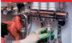
8. Подсоединение петель теплого пола к коллекторному блоку. Гидравлические испытания
