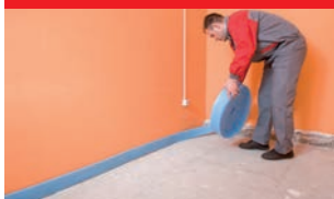
6. Укладка утеплителя (пенополистирол с покрытием)
