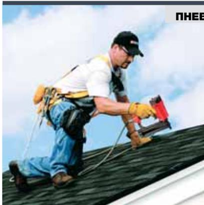
**ПНЕВМОСТЕПЛЕРЫ** – инструменты, предназначенные для забивания крепежа без применения физической силы; в качестве источника энергии для забивания гвоздя служит сжатый воздух. По типам расходных материалов делятся на гвоздезабивные, скобозабивные, шпилькозабивные. Расходные материалы не только определяют тип крепежа, но и его размер, калибр и материал, для которого они подходят. Так например нельзя гвоздем для древесины прибивать что-то к бетону.
